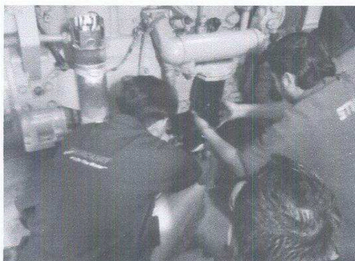
Mantenimiento preventivo de la planta eléctrica del Palacio Nacional de La Cultura, cambiando accesorios originales de la marca CAT
